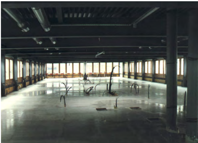
Aufstockung der stützenfreien Kommandozentrale mit einer Stahlstruktur und einer schweren schalldämmenden Gebäudehülle
