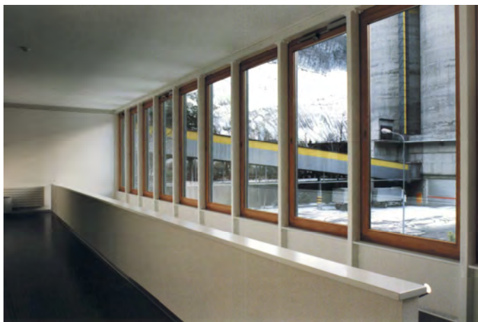
die bündige Fassade trägt dem feinen Zementstaub Rechnung
