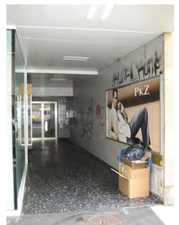
Hauszugang vor dem Umbau
