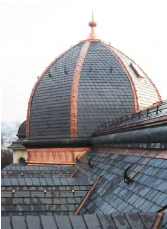
einzelne Spengler-Elemente wie die Grate der Kuppel, sowie deren Dachspitze und Simse wurden in einer vereinfachten Art wiederhergestellt
