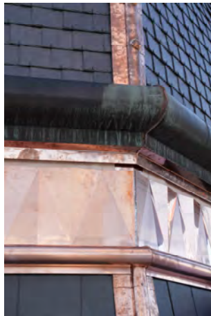
einzelne Spengler-Elemente wie die Grate der Kuppel, sowie deren Dachspitze und Simse wurden in einer vereinfachten Art wiederhergestellt
