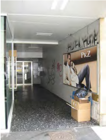
Hauszugang vor dem Umbau
