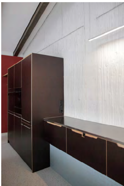
der Schubladnkörper liegt auf dem alten Schwimmbeckenrand
