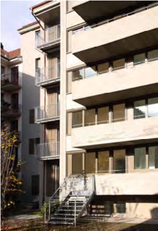
die sanierten Fassade gegen den Hof
