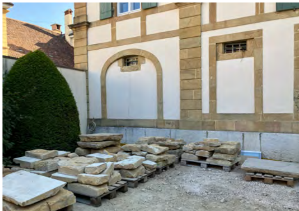
Abbruch und Ausbau der massiven Steinplatten über dem Gewölbe des Erdgeschosses.
