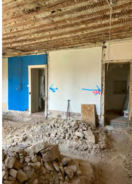
Abbruch und Ausbau der massiven Steinplatten über dem Gewölbe des Erdgeschosses.
