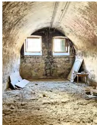
Auch im Erdgeschoss ist der Steinboden bereits ausgebaut und wartet im Steinwerk auf die Verlegung im Rahmen der zweiten Etappe.
