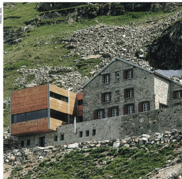
Cabane Tschierwa, projet et exécution de l'agrandissement 1997-2003/architectes : Hans-Jörg Ruch avec Toni Spirig. L'annexe ne constitue pas seulement un agrandissement, par
